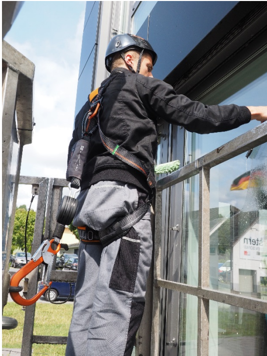
Abb. 2-3: Einsatz von PSA gegen Absturz beim Aufenthalt im Arbeitskorb einer Hubarbeitsbühne
