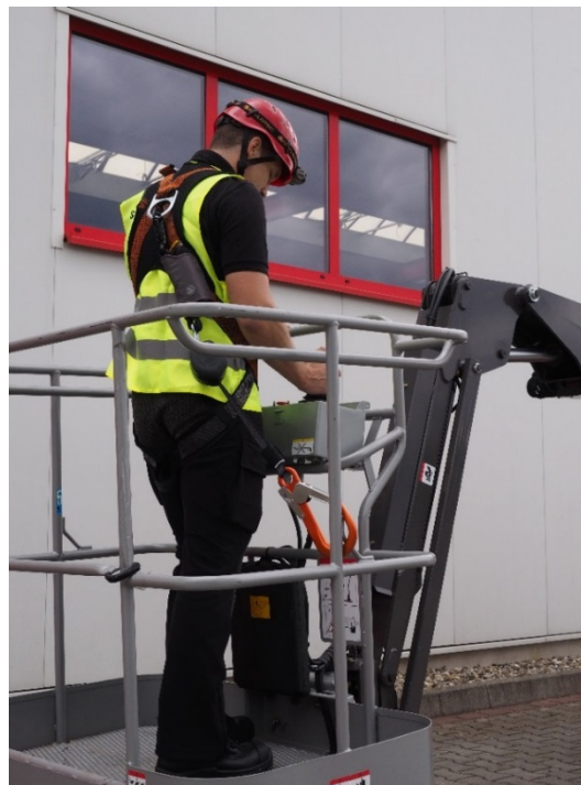
Abb. 2-3: Einsatz von PSA gegen Absturz beim Aufenthalt im Arbeitskorb einer Hubarbeitsbühne
